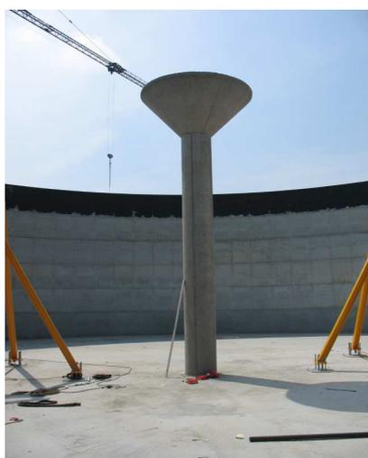
PARTICOLARE INTERNO DIGESTORI—PILASTRO SOSTEGNO
